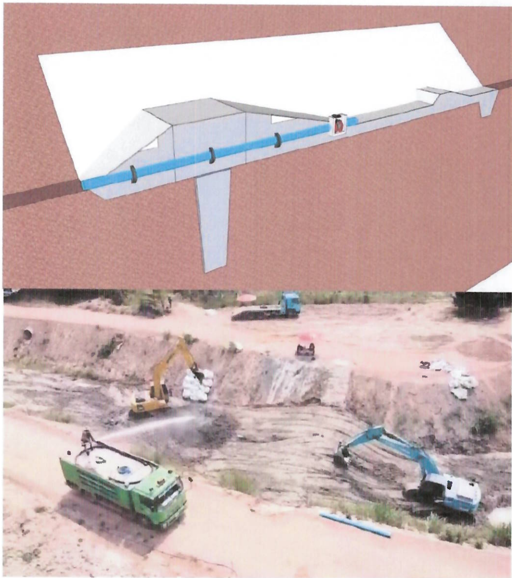
ภาพที่ 10 แสดงการบดอัดตัวฝายและการวางท่อระบาย
