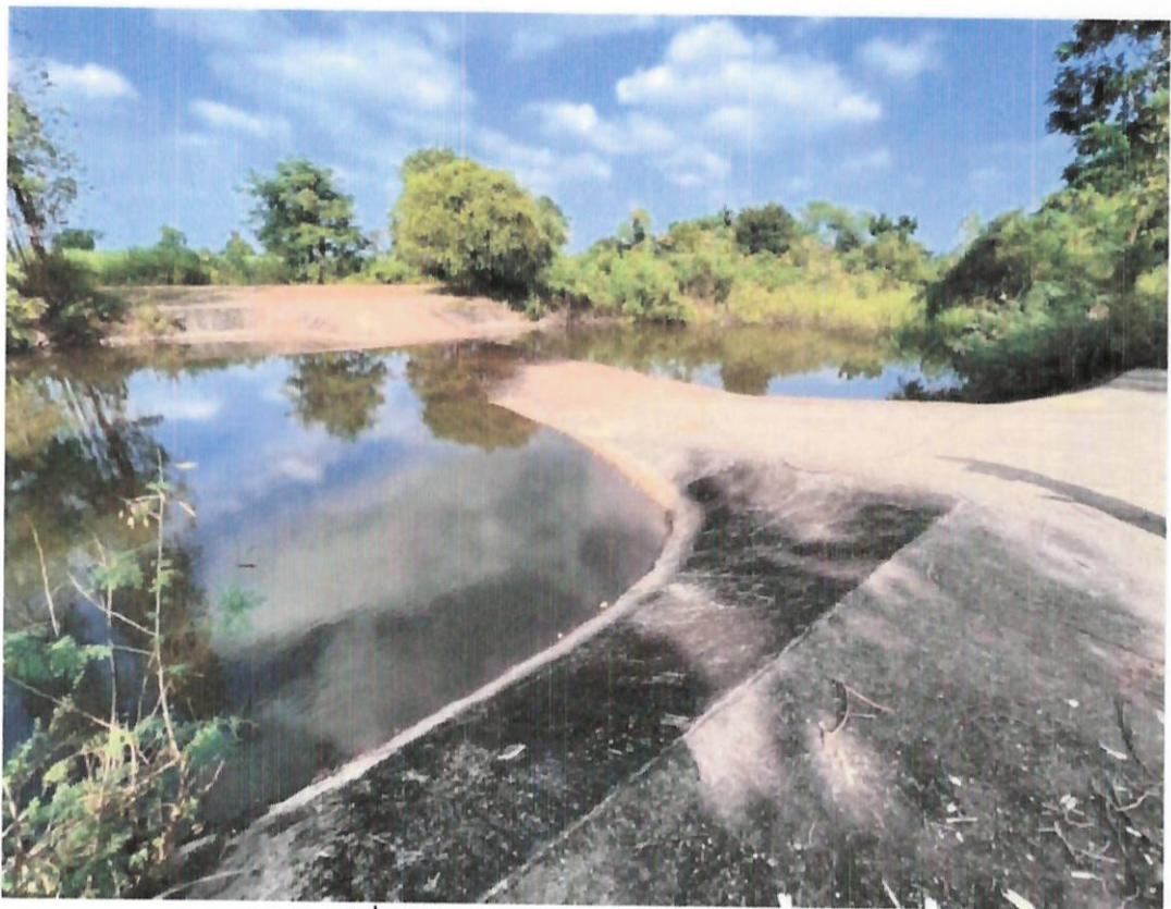
ภาพที่ 1 ตัวอย่างฝายแกนดินซีเมนต์ที่ผ่านการใช้งาน
