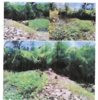
ฝายแกนดินซีเมนต์ห้วยยางบง 2 ต.ท่านางแหว อ.แวงน้อย จ.ขอนแก่น
