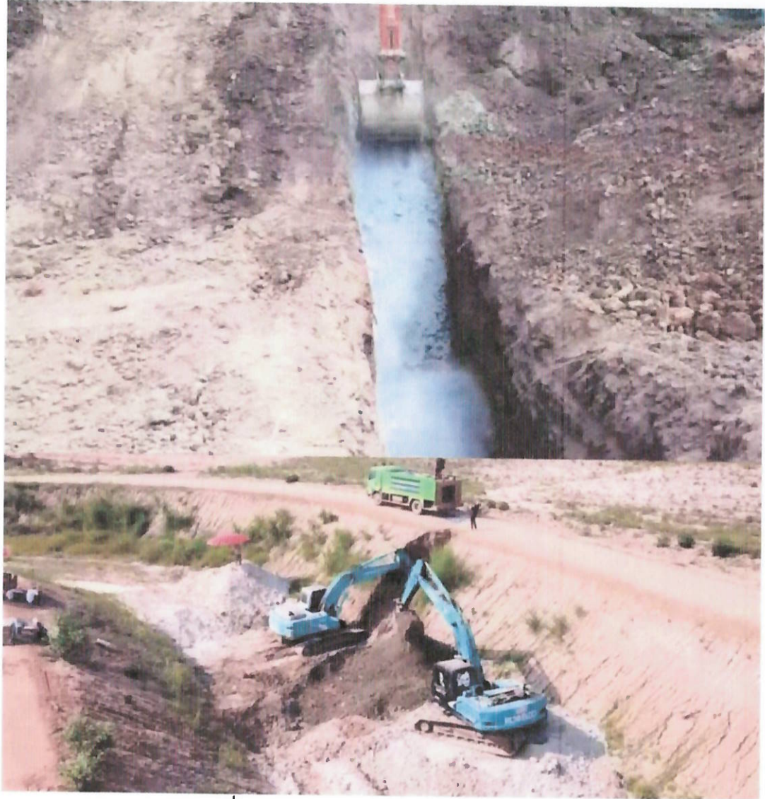
ภาพที่ 7 แสดงการขุดคูฝาย และร่องแกนและบดอัดดินซีเมนต์กลับ
