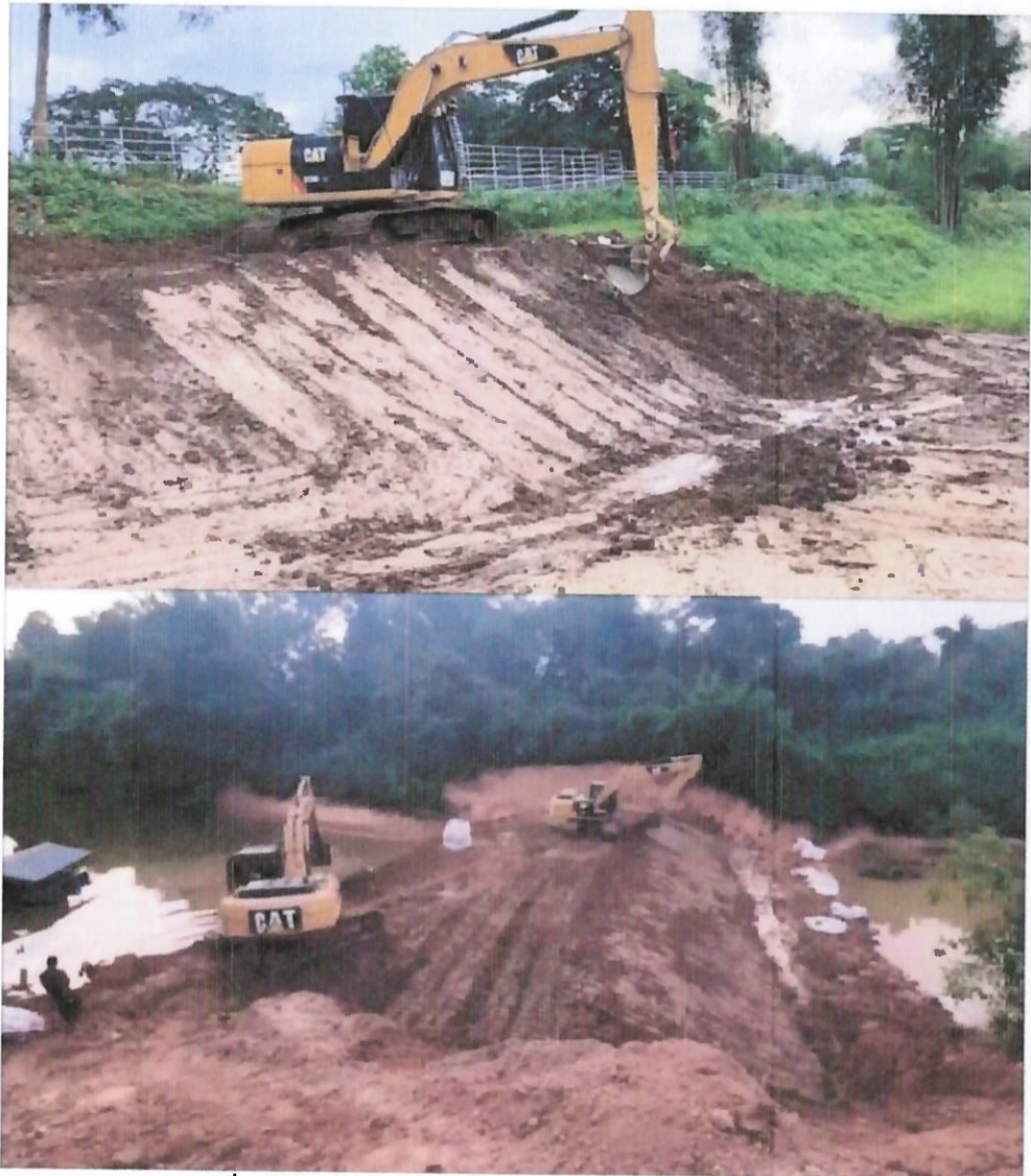
ภาพที่ 8 แสดงการขุดลอกหน้าดินลาดสโลป และการบดอัดดินซีเมนต์กลับ
