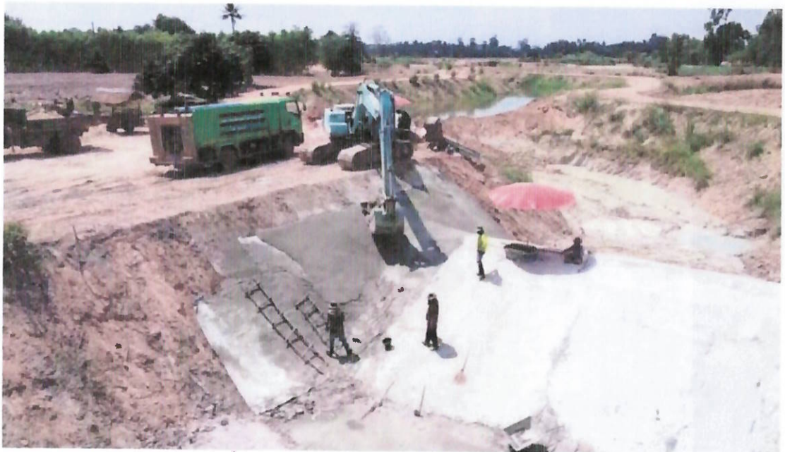
ภาพที่ 11 แสดงการปูแผ่นใยสังเคราะห์และฉาบด้วยน้ำปูน
